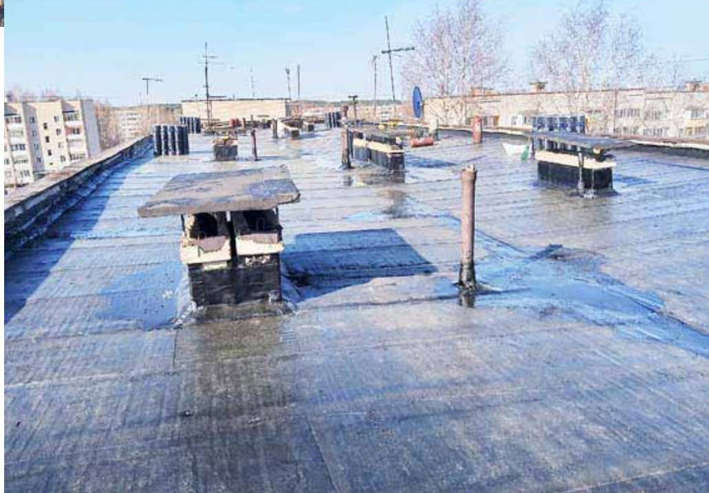
Ул. Профсоюзная, 1. Устройство нижнего слоя кровельного ковра
